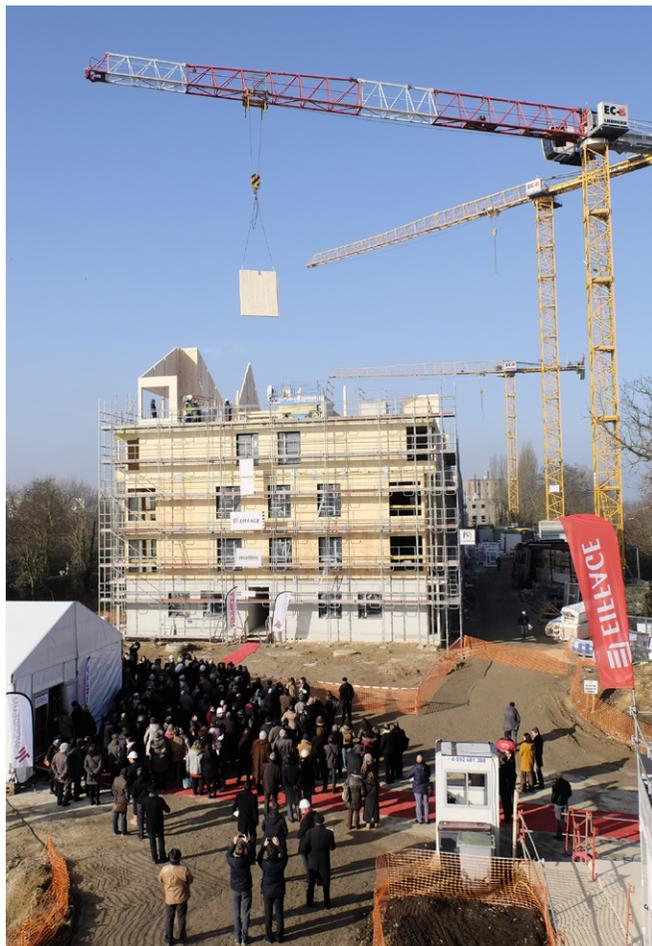
Le 21 janvier 2016 avait lieu la pose du dernier voile de bois massif CLT du projet du quai de la Borde. Le promoteur immobilier Promicea souligne que la préfabrication en usine, la filière sèche ainsi que la simplicité des assemblages d'une structure en bois massif CLT permettent de diviser par deux la durée de la phase gros œuvre. Avec 3 grues, chaque étage de la structure bois a été montée en à peine 6 jours dans un silence absolu.
