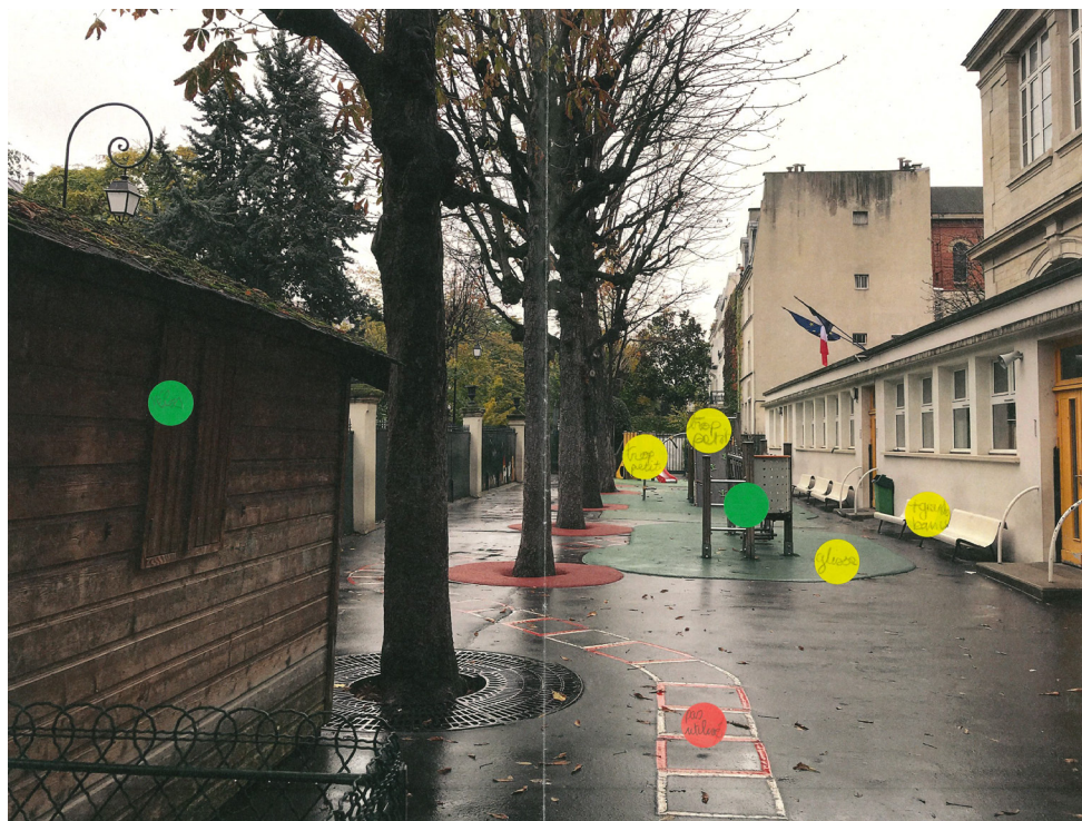
Diagnostic de l'état de la cour
