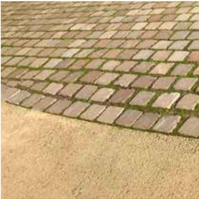
*Unión entre los adoquines con pasto y el concreto drenante por medio de una lámina metálica*
