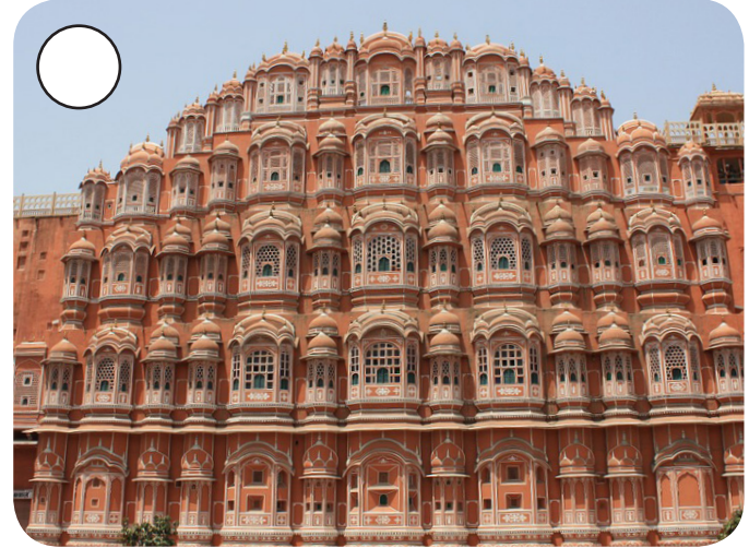
À Jaipur, en Inde, le Palais des vents permet à l'air de circuler par les claustras (parties ajourées) de la façade.
