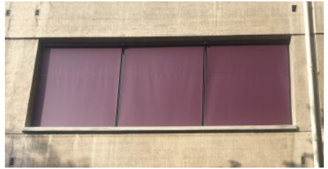
Pose de stores électriques
