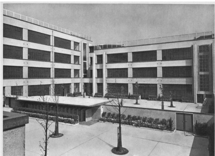
La cour des filles, à l'arrière plan celle des garçons
