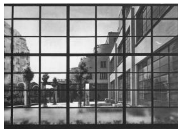
Les menuiseries en acier des baies
