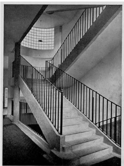
L'escalier du bâtiment « garçons » et sa façade courbe traitée en pavés de verre
