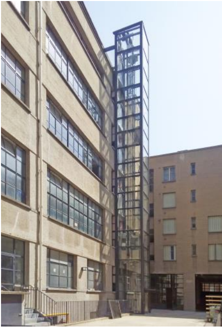
Construction d'une cage d'ascenseur
