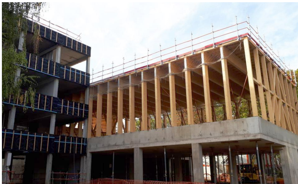
Vue de l'extension en chantier. Des voiles béton en partie basse supportent une ossature bois. Photo : Bouygues Bâtiment
