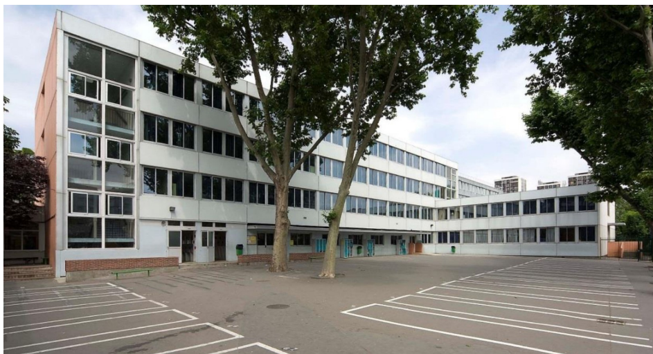
La façade sud du collège avant les travaux. Au premier plan, la cour de récréation.
