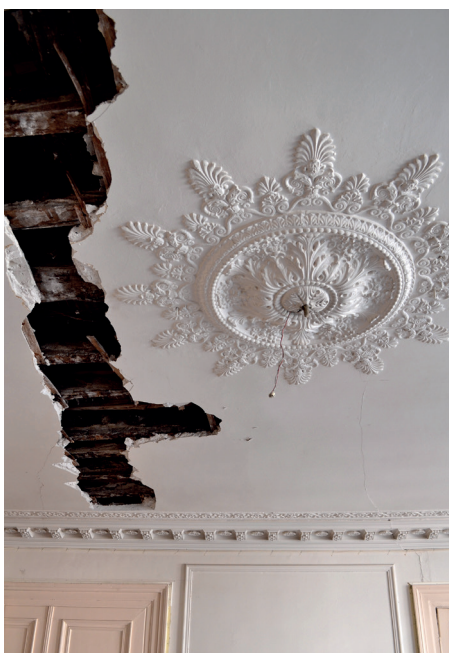
Photos du chantier
