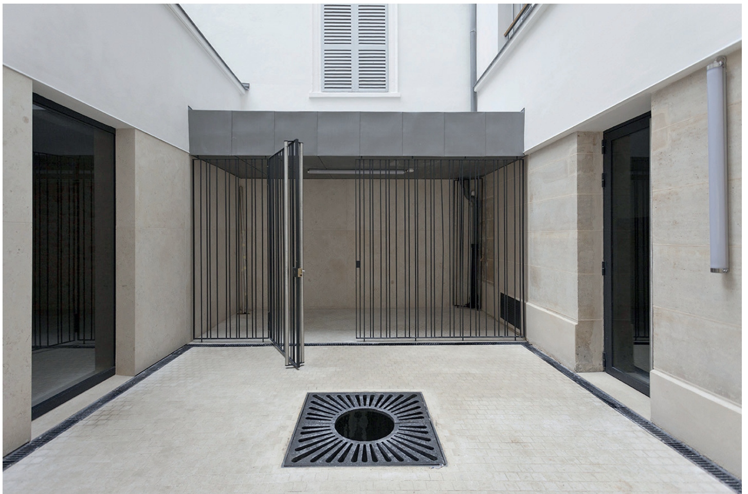
Cour intérieure pavée et local vélos
