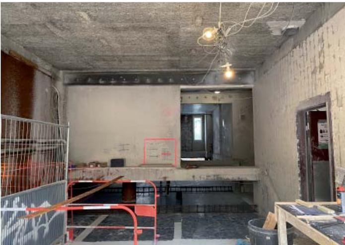
renforcement des poutres ph RDC par des profils acier moisés pour reporté la charge qui reposait sur le RDC haut. (escalier du R+1 au R+12).
