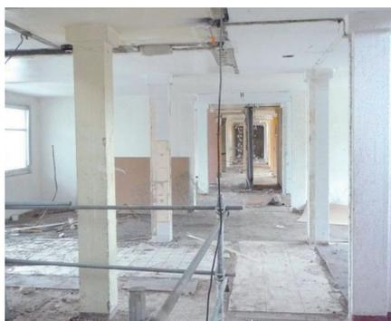
Images du chantier laissant apparaître la grille structurelle (poteau et plancher) du procédé Camus
