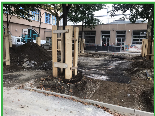
Protection adaptée Encadrement rigide en bois autoportant
