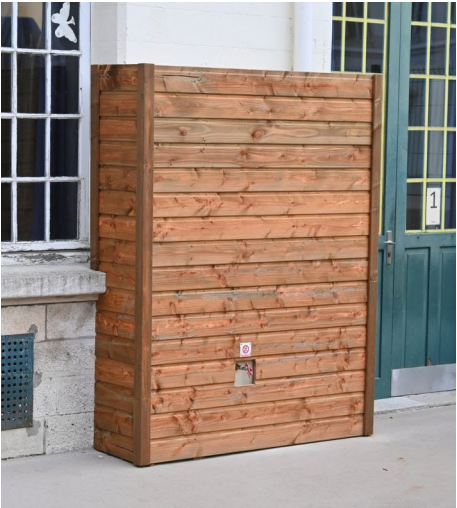
Un des récupérateur d'eau de pluie de l'école maternelle Chardon Lagache (Paris 16 e ) protégé des élévations importantes de température par son habillage en bois © Laurent Bourgogne - Ville de Paris
