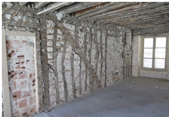
[ill. 1] Intérieur immeuble ossature bois
