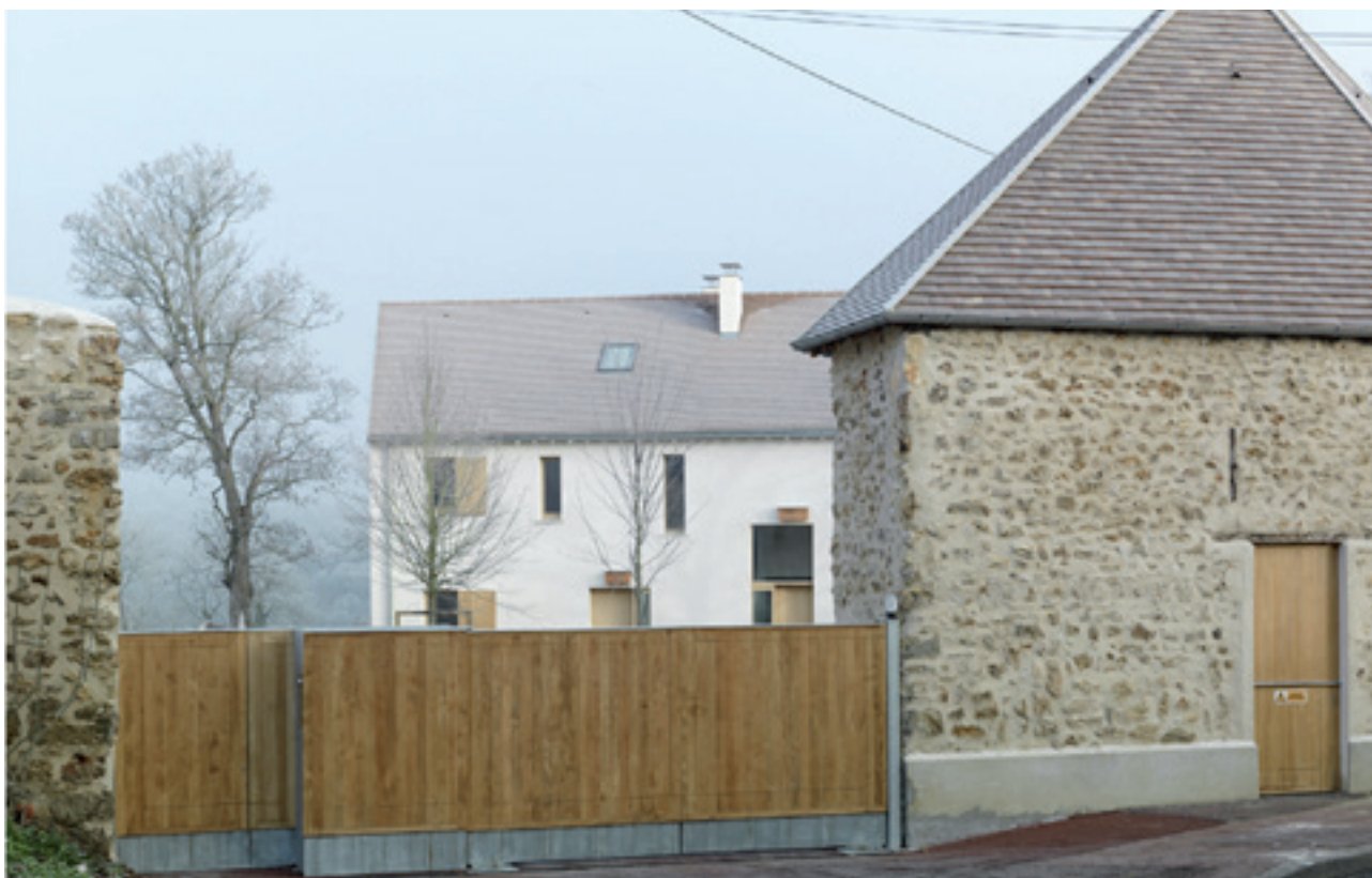
Vue depuis la rue de la Folie sur l'entrée et le bâtiment reconstruit, abritant les parkings
