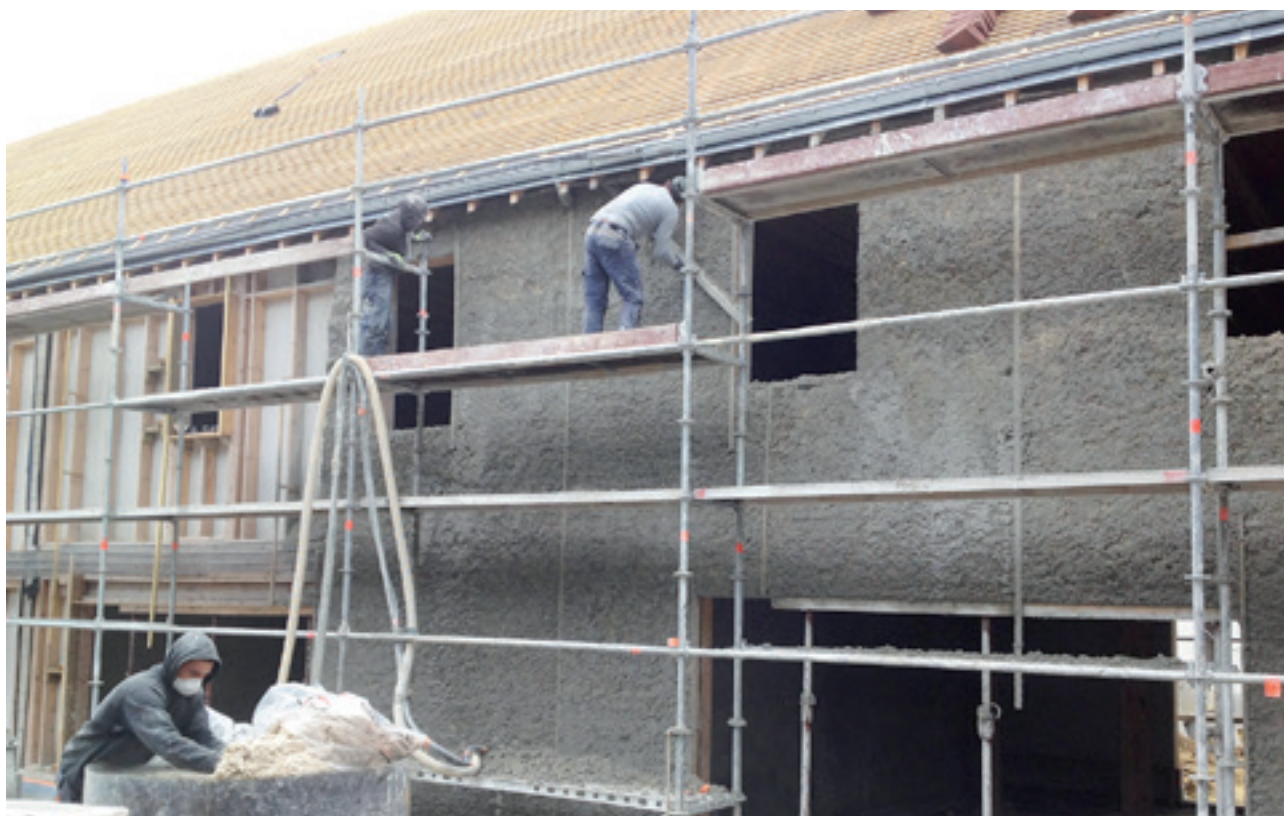
Projection du béton de chanvre sur les panneaux d'ossature
