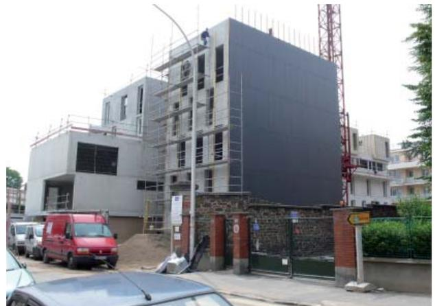
Vue d'ensemble du chantier. Pose des bardages du bâtiment sur rue.
