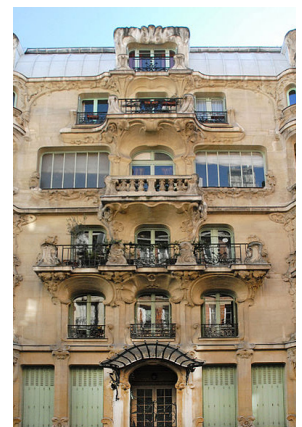
Immeuble Les Arums, Paris 7 ème
